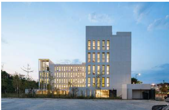
2015 EDIFICIO OFICINAS HABITAT
